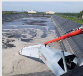
Fosse à géomembranes
